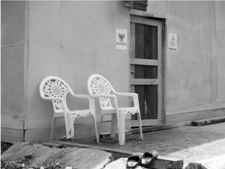
Hunian sementara yang dibuat BAZNAS - Dompot Dhuafa bagi para korban gempa di Bengkulu pada 12 September 2007.
